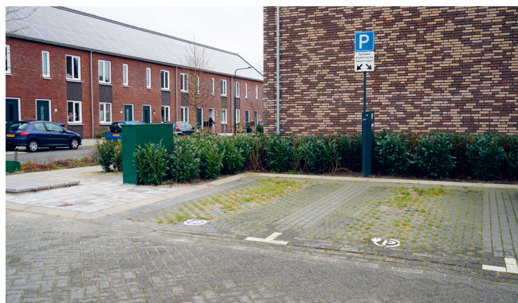
Waterdoorlatende parkeerplaatsen in Roelofarendsveen
